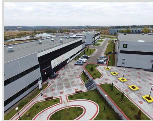
Вид на корпуса Наноцентра «Техноспарк» с квадрокоптера. Октябрь, 2015
